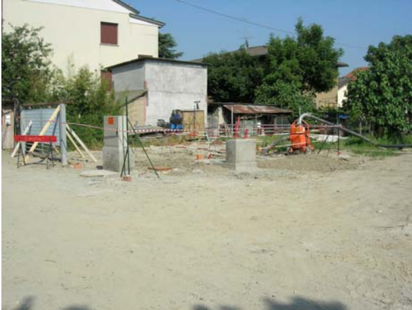
Francolino: i lavori fermi da un anno
