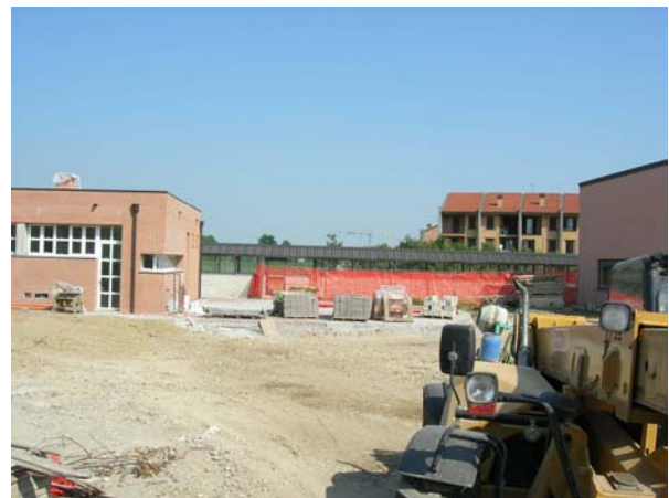
Scuole: ancora lavori in corso e la palestra non verrà mai realizzata da questa Amministrazione.
