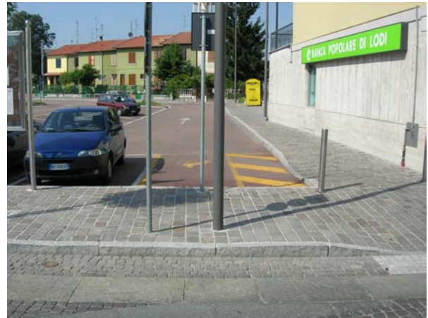
Piazza Colonna: il marciapiede che l'Amministrazione vuole eliminare
